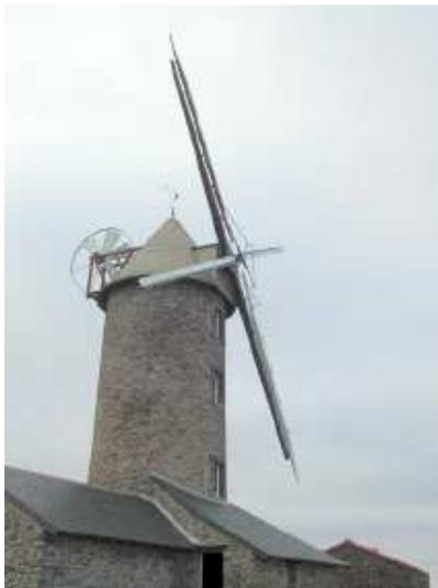
**La voilure des ailes est repliée selon le principe Berton (XIXe siècle), mais piloté à l'aide d'un vérin répondant aux ordres de l'automate ABB AC500.**
